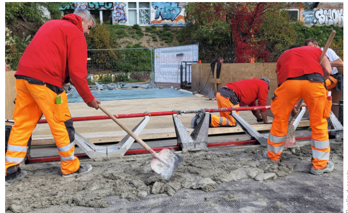
Bild 11 Einbau vor der Rüttelbohle UHFB before the vibrating beam
