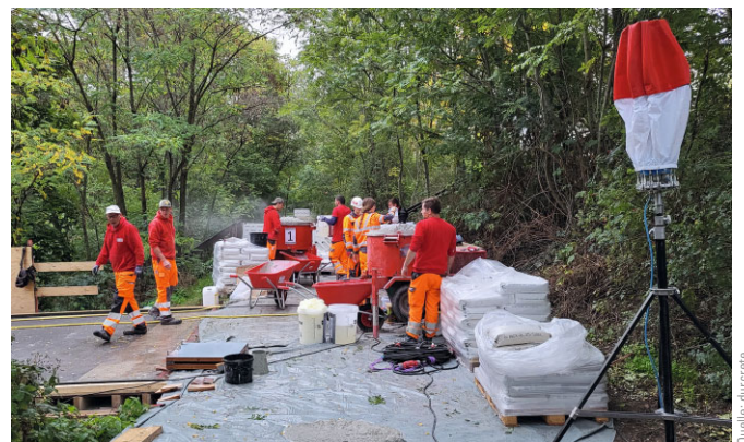
Bild 8 Zwangsmischer und Ausgangsstoffe für die Herstellung von UHPFB Compulsory mixers and raw materials to produce the UHPFRC
