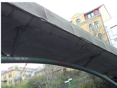
Bild 3 Zustand des Brückendecks vor der Instandsetzung Condition of the bridge deck bevor repair
