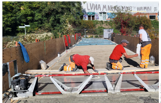
Bild 12 Nachbehandlung Curing and finishing
