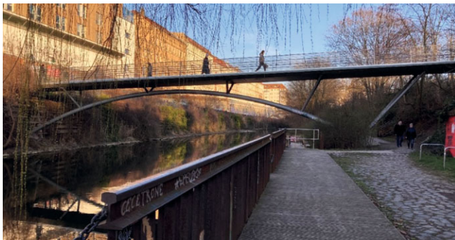
Bild 1 Ansicht der Brücke Karl-Heine-Bogen View of the bridge Karl-Heine-Arch
