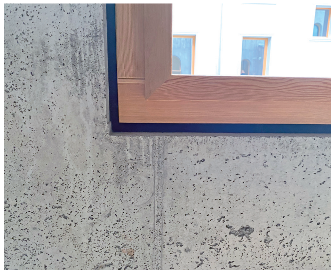
Bild 4: Beispiel für eine typische Oberflächenstruktur eines Infraleichtbetons
