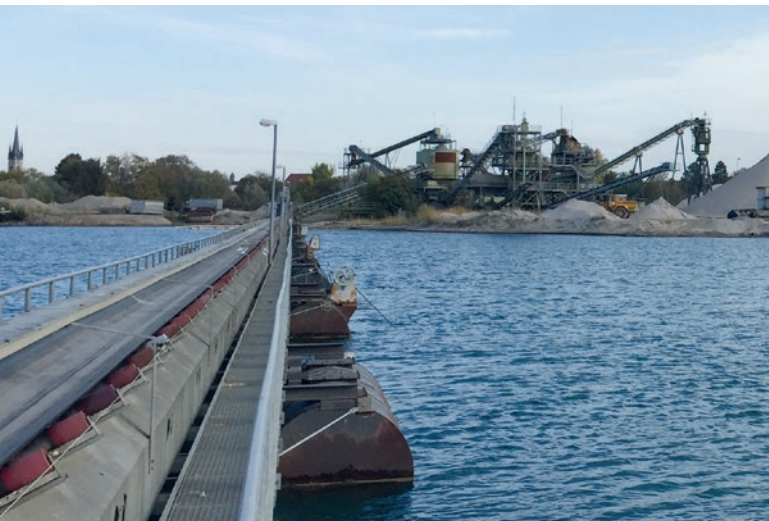
Abb. 2: Dyckerhoff Kieswerk Trebur, Deutschland
