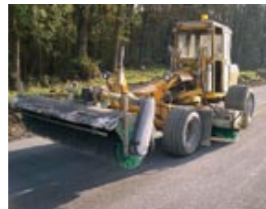
Bild 16: Ausbürsten des Oberflächenmörtels
