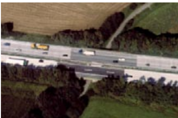
Bild 1: Bundesautobahn A44 Unna-Kassel mit Asphalt- und Betonfahrbahndecke (untere Fahrbahn mit CEM III, obere Fahrbahn mit CEM I)
