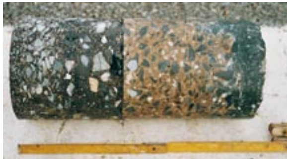
Bild 5: 1999 entnommener Bohrkern aus der BAB A4 bei Merane
