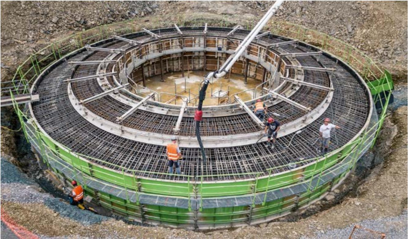
Mit einer Betonpumpe wird der Transportbeton vom Fahrmischer in das Fundament befördert.
