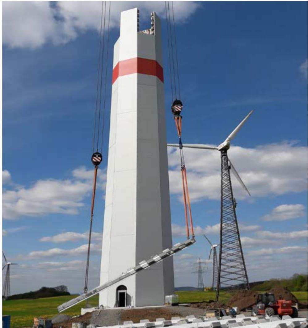
Die VENTUR Windtürme werden in vorgespannter Fertigteilbauweise errichtet. (Foto: VENTUR GmbH)
